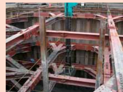
仮設鋼矢板、切梁、腹起し
