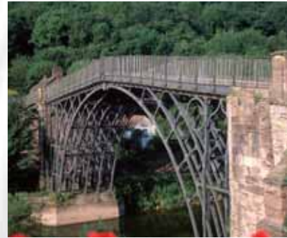
1779年に高炉の鑄鉄で建造された世界初の鉄橋（イギリス・ダービー / 世界遺産に登録）
