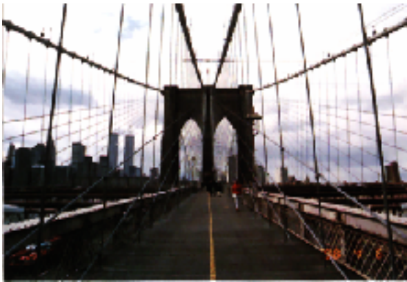
車道より高い位置にある歩道
