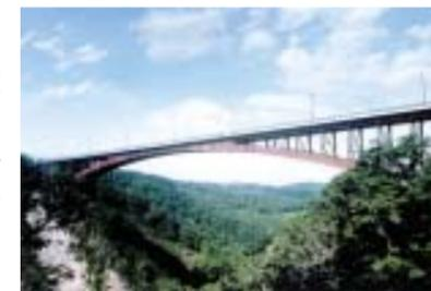
ニッケル系高耐候性鋼橋梁 (さび安定化補助処理)
