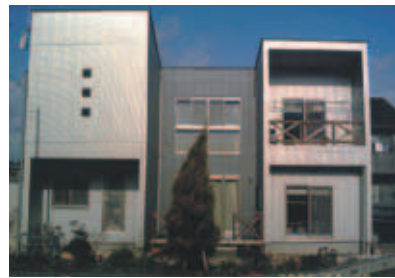
地区：福島県 応募社名：光和建材㈱ 施主：日邸 講評：凹凸部を強調し、建物形状にメタル特徴を生かした近代的建物仕上げ。
