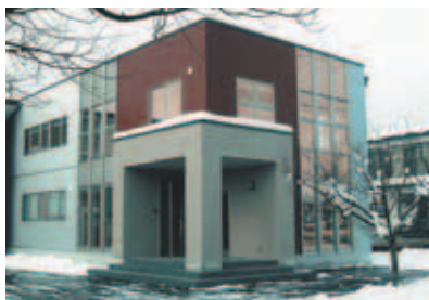
地区：秋田県 応募社名：㈱丸茂組 施主：K邸 講評：金属サイディングの濃淡と、ガラスのカーテンウォールを組み合わせたインパクトのある外観。
